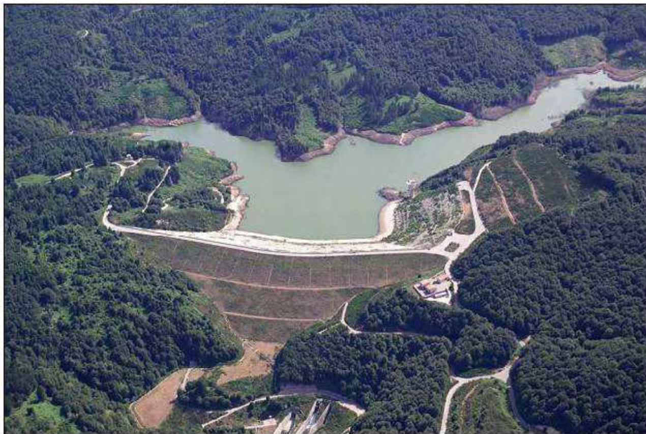
Lo sbarramento lungo il Metramo nel territorio di Galatro.
